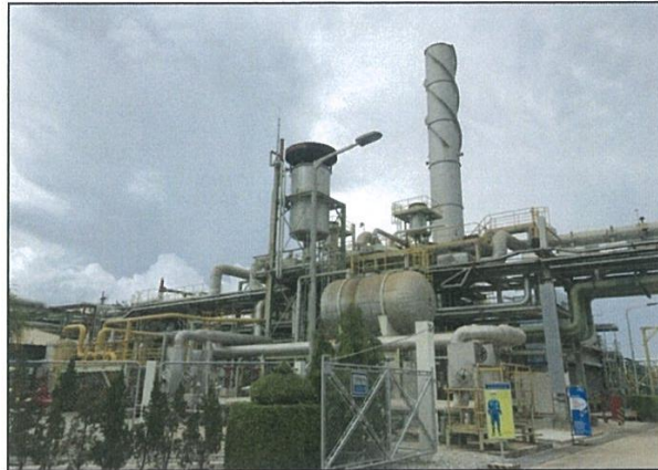
หม้อไอน้ำสำรอง (Auxiliary Boiler)
