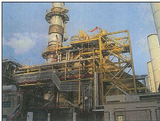
เครื่องกำเนิดไอน้ำจากความร้อนที่เหลือ (Heat Recovery Steam Generator : HRSG)
