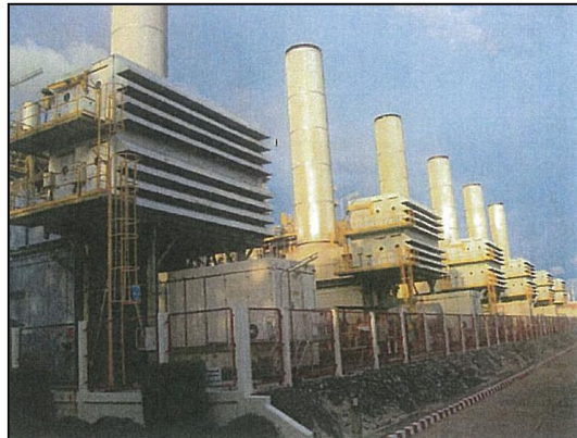
เครื่องกำเนิดไฟฟ้ากังหันก๊าซ (Combustion Turbine or Gas Turbine Generator)
