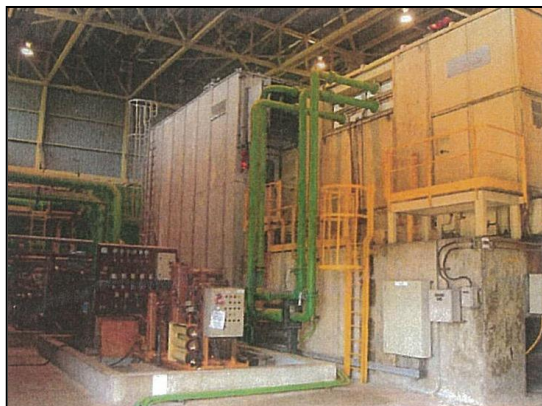
เครื่องกำเนิดไฟฟ้ากังหันไอน้ำ (Steam Turbine Generator)
